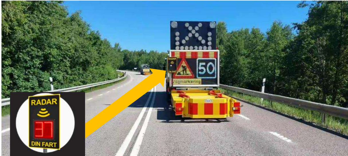
Bild 6, Radarmätningar utförda vid linjemålning.
